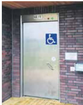
Der Schlüssel öffnet WC an der Autobahn.
